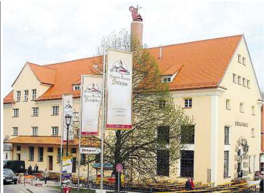
Die Ruhe vor dem Sturm: Festlich vorbereitet erwartete die renovierte Klosterbrauerei vormittags die Besucher, die dann auch in Scharen kamen. Fotos: Gruber
